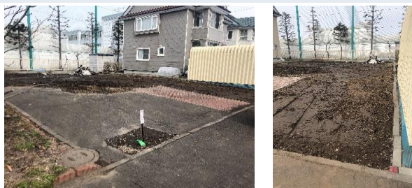
令和2年2月 撮影 現況 更地
